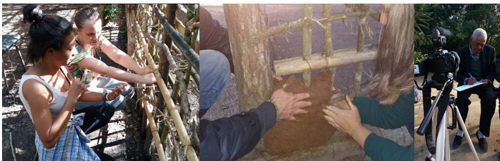
Figuras 1 a 3 – Amarração da malha da parede, barreamento do Mocambo e registro da tradição oral do Griô Volnei Jesus no quilombo do Boqueirão. Fonte: Arquivo dos autores.
