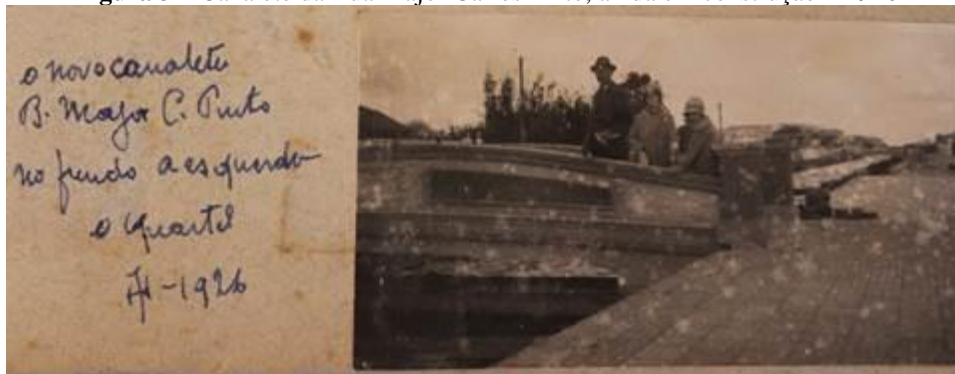
Figura 3 – Canaleta da Rua Major Carlos Pinto, ainda em construção – 1926
