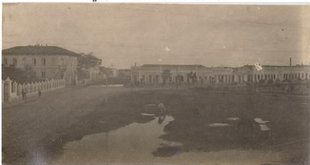
Figura 1 – Vista da Rua 24 de Maio – 1912
