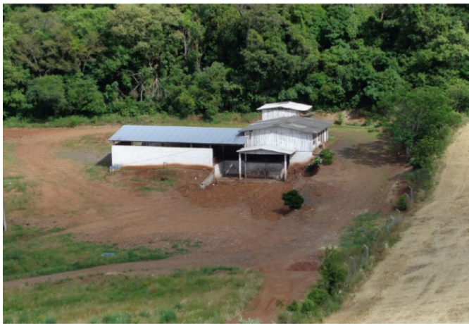
Figura 8: Vista superior da Usina de Triagem atual em fase de readequação.
