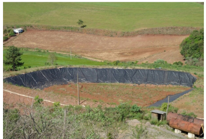
Figura 9: Célula do atual Aterro Sanitário de Sananduva.
