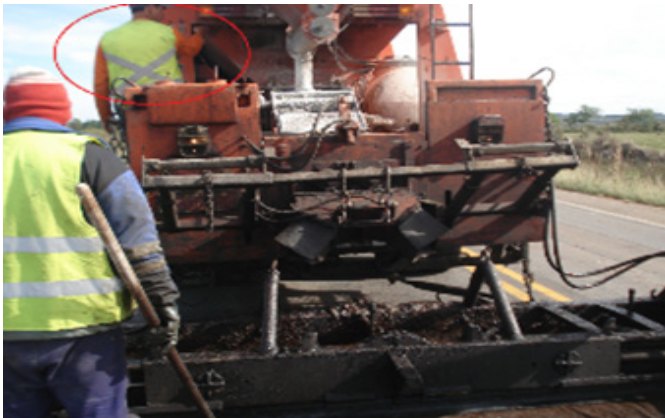
Figura 2. Alimentação de água da mistura na usina de MRAF. Fonte: Autores
