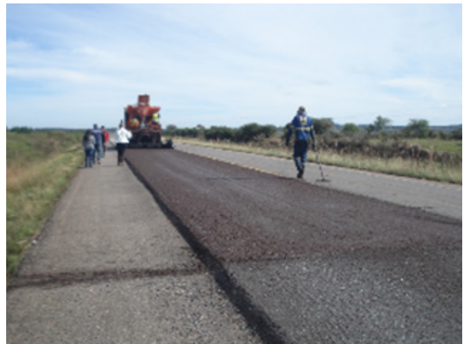
Figura 1. Camadas de MRAF executadas sobre o pavimento do segmento estudado. Fonte: Autores
