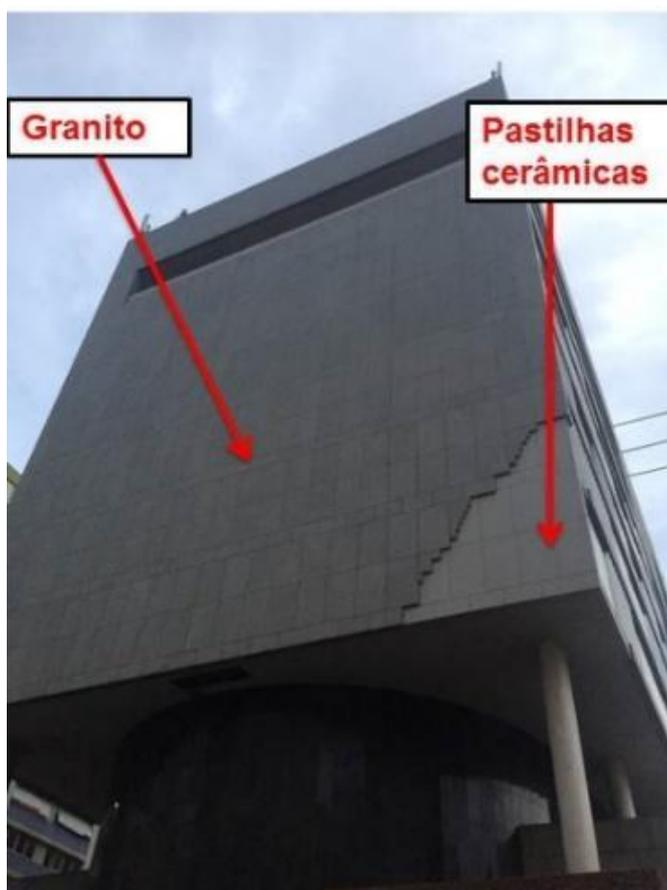
**Figura 5:** Fachada Norte, recorte no granito deixando aparentes as pastilhas cerâmicas. Fonte: Registro fotográfico realizado pelo autor, 2021. Adaptado pelo autor.
