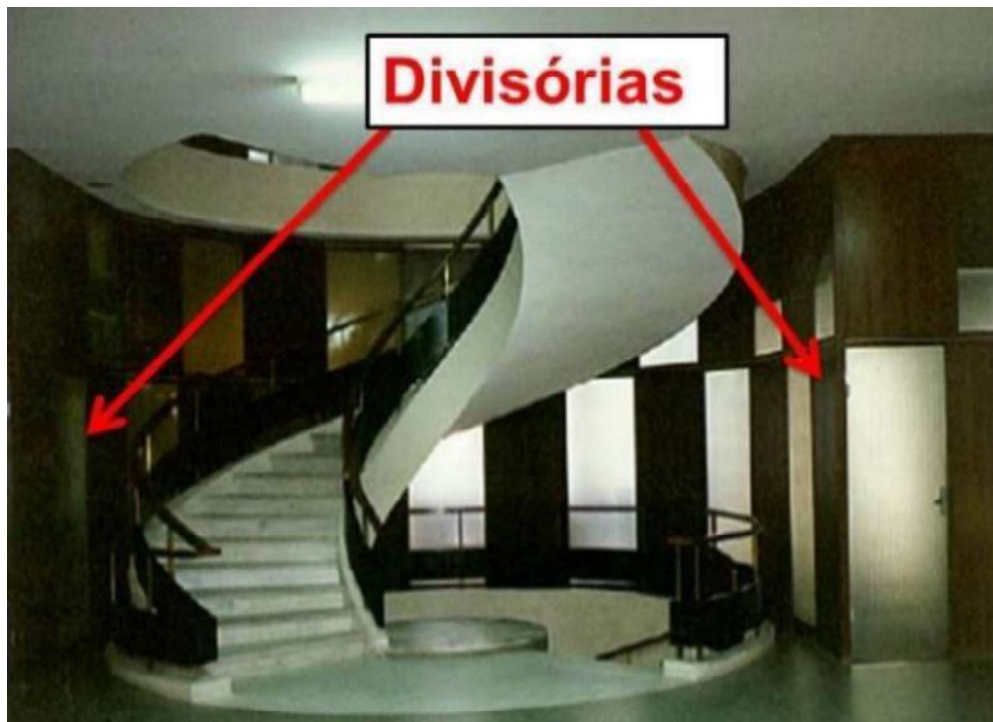
Figura 2: Divisórias no entorno da escada helicoidal. Fonte: Cícero Alvarez, fotógrafo, 2002 (ALVAREZ, 2008 p. 146). Adaptado pelo autor.
