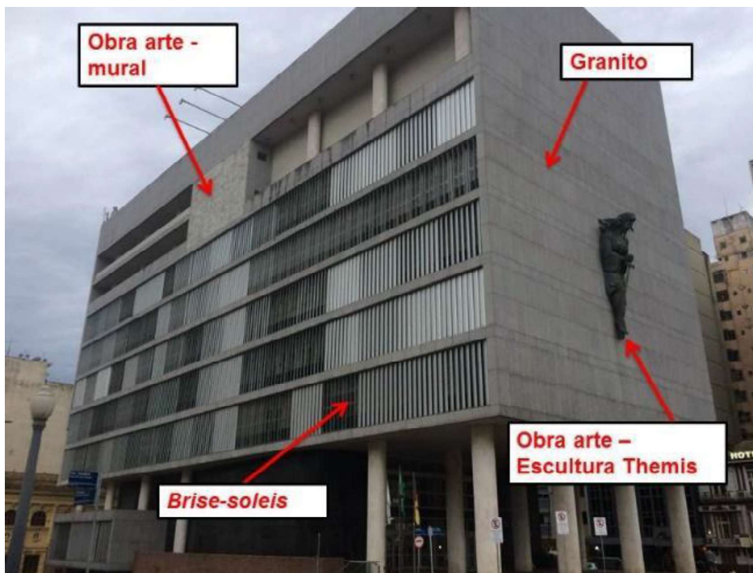
Figura 7: Inserções na ocasião do restauro, obras de arte, brise-soleis e granito. Fonte: Registro fotográfico realizado pelo autor, 2021. Adaptado pelo autor.
