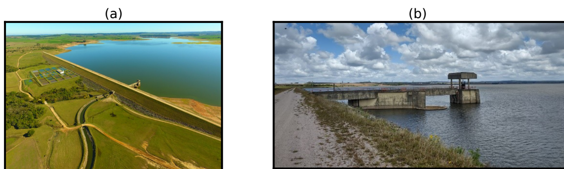
Figura 1 - Barragem do Chasqueiro: (a) vista geral; e (b) detalhe do vertedouro.
