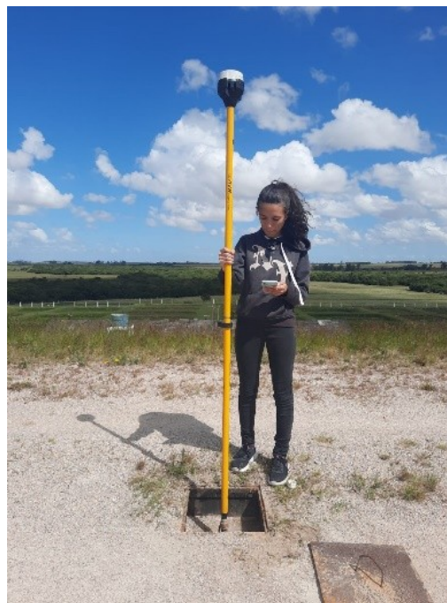
Figura 4 - Piezômetro detectável na crista da Barragem do Chasqueiro Fonte: os autores
