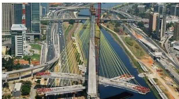
**Figura 11** – Construção da Ponte Otávio Frias de Oliveira
