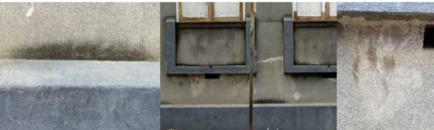
Fig. 26 – Manchas. Edificação “32-1151”. Fig. 27 - Fissuras e trincas. Edificação “32-1151”. Fig. 28 – Eflorescência. Edificação “32-1151”. Figura 29 - Manchas. Edificação “194-1644”. Fig. 30 – Aplicação de outro material. Edificação “194-1644”. Fig. 31 – Fissuras e trincas. Edificação “194-1644”. Fonte: Autora, 2021. Quadro 3 - Quadro de resultados do mapa de danos da edificação “194-1644”. Fonte: Autora, 2022.
