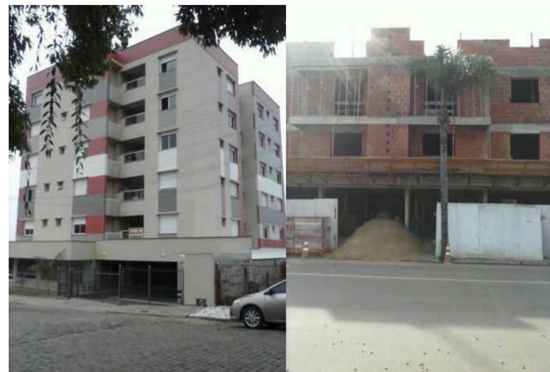
Figura 2 – Prédio residencial/comercial. Fonte: acervo do autor (2020). Figura 3 – Prédio em construção no centro. Fonte: acervo do autor (2020).
