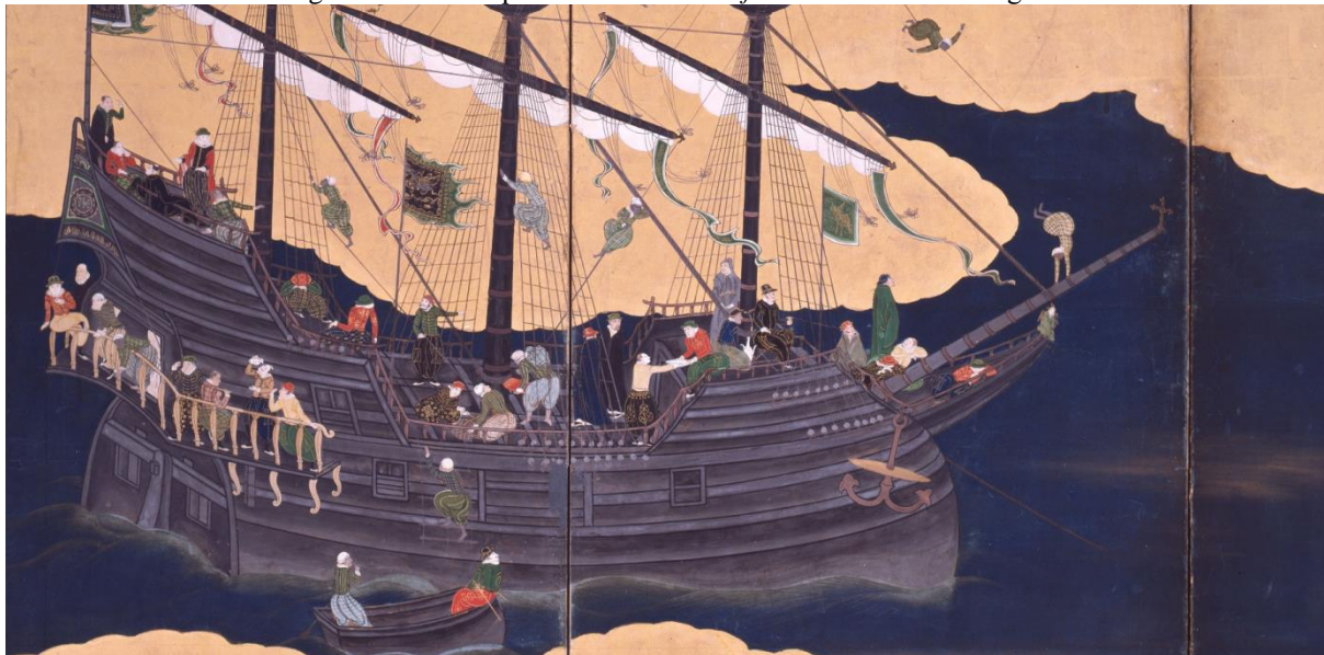
Figura 4 – Vista Aproximada do “ Kurofune ” ou Navio de Cargas.
